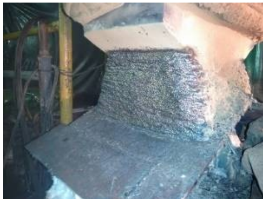
Início da soldagem
