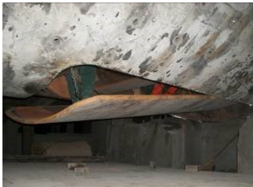
Posicionamento de segmento novo
