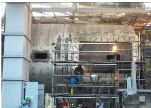
Soldagem de segmento novo
