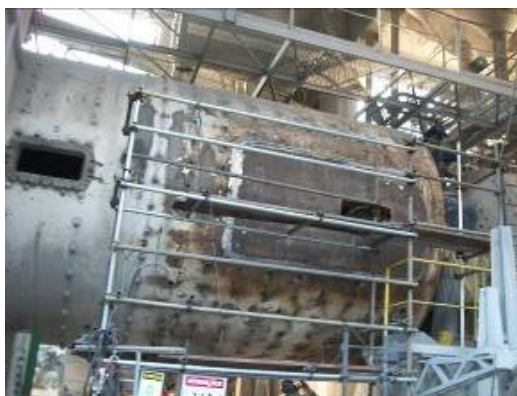
Segmento novo instalado
